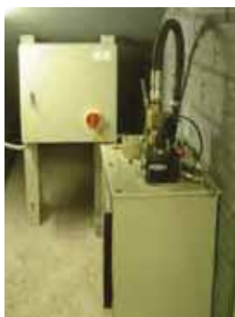
Equipo Hidráulico / Hydraulic Equipment
